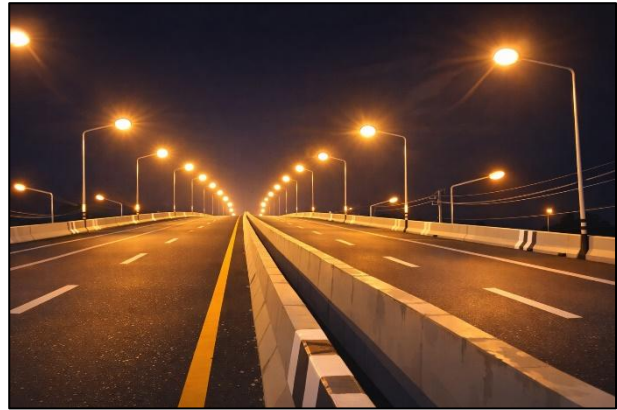
รูปที่ 8 ภาพตัวอย่าง เสาไฟฟ้าแสงสว่างบนสะพาน
