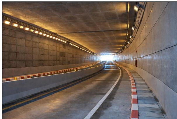
รูปที่ 9 ภาพตัวอย่าง การติดตั้งหลอดไฟ LED บนกำแพงทางลอด
