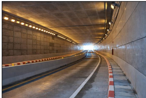
รูปที่ 11 ภาพตัวอย่าง การติดตั้งหลอดไฟ LED บนกำแพงทางลอด
