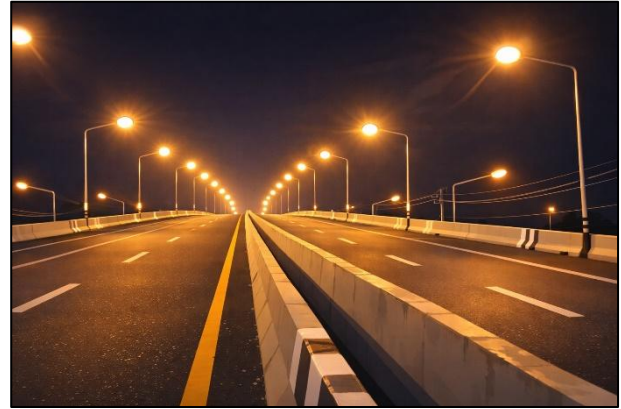
รูปที่ 10 ภาพตัวอย่าง เสาไฟฟ้าแสงสว่างบนสะพานยกระดับ
